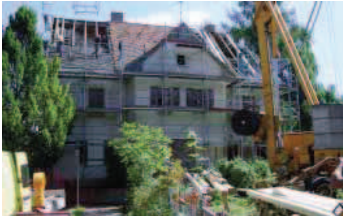
Am 30. August haben die Sanierungsarbeiten an der Haydn-Villa begonnen. Hier im Bild sind die Zimmerer fleißig am Werk.
